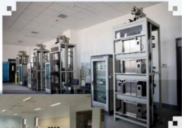
智能电梯安装调试 维护训练场所
